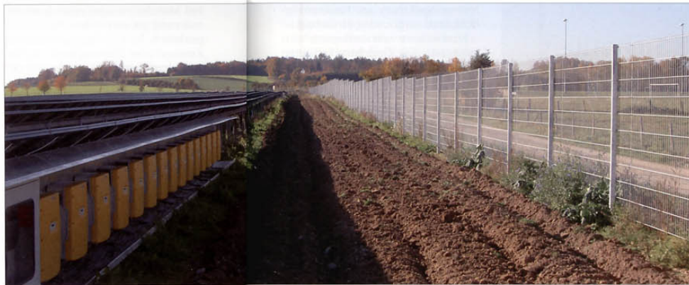
Geländesicherung durch 1 250 m Flachstab-Gittermattenzaun – die Querverstrebung aus Flacheisen (15 mm x 6 mm) kann mit einem handelsüblichen Bolzenschneider Angriffspunkt für Übersteigversuche
